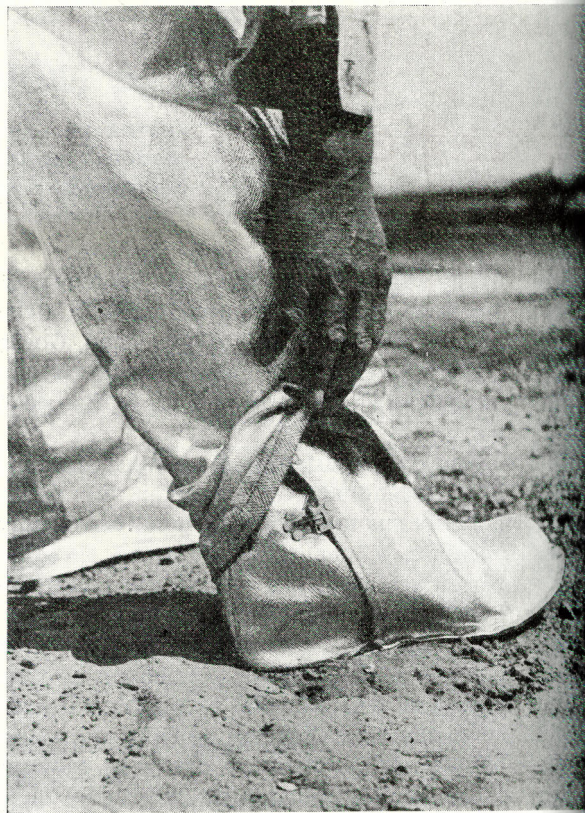
Las botas que se llevan con el traje para combatir incendios Essgee 75, fabricado por Siebe, Gorman and Company Ltd., Davis Road, de Chessington, Surrey, Inglaterra, consisten en un par interior de piel flexible con suelas sintéticas, y otro exterior de un material termorreflector, parecido al del traje, con suelas de fibra artificial.
